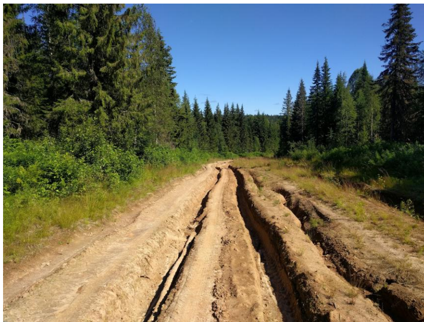
Рисунок 3.13 - Колея на дороге местного значения
